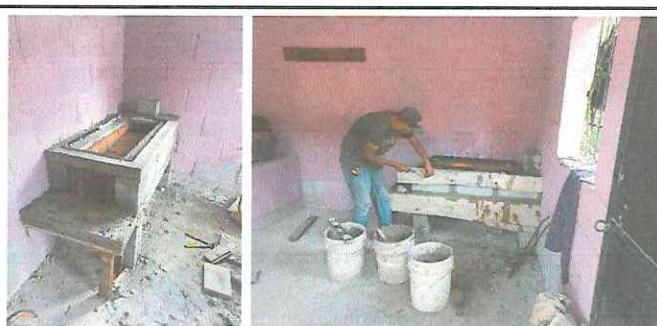
FOTO 6: CONSTRUCCIÓN DE ESTUFA RURAL CON CHIMENEA EN COCINA.
