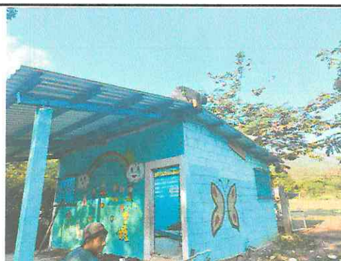
FOTO 4: INSTALACIÓN DE CUBIERTA DE LÁMINA TROQUELADA.
