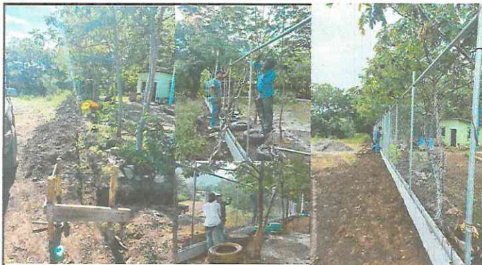
FOTO 1: CONSTRUCCIÓN DE MURO PERIMETRAL CON BLOCK Y MALLA.
