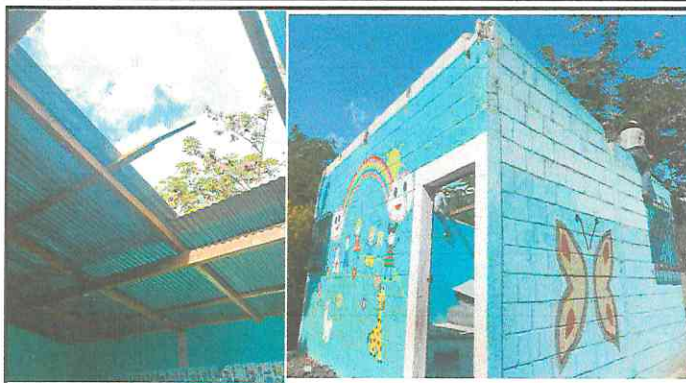
FOTO 2: DESMONTAJE DE LÁMINA EN MAL ESTADO.
